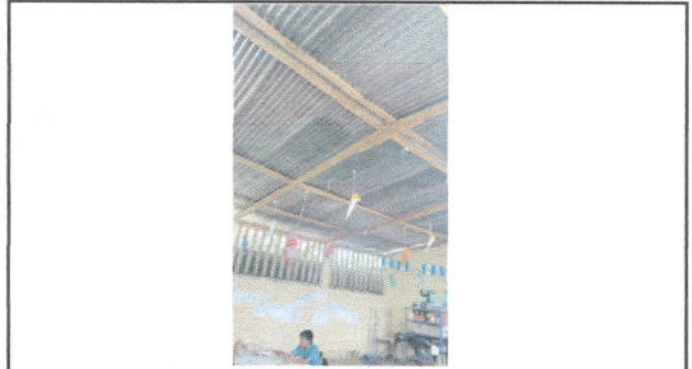
Foto 2: Sustitución de lámina por lámina troquelada Aluzin calibre 26 en aula; sustitución de estructura de soporte de madera por metal en servicio en aula
