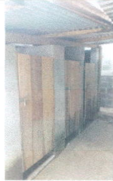
Foto 14: Frabricación e instalación de puertas de metal en baños
