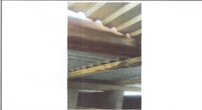
Foto 1: Sustitución de lámina por lámina troquelada Aluzin calibre 26 en servicio sanitario; sustitución de estructura de soporte de madera por metal en servicio sanitario
