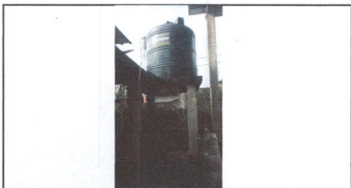
Foto 11: Sustitución de depósito de agua 1,100 litros
