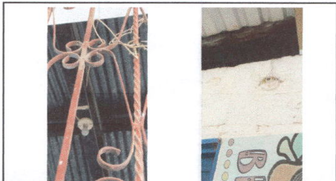
Foto 9: Sustitución de focos ahorradores plafoneras
