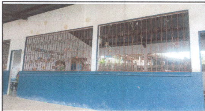
Foto 7: Pintura en muros exteriores e interiores
