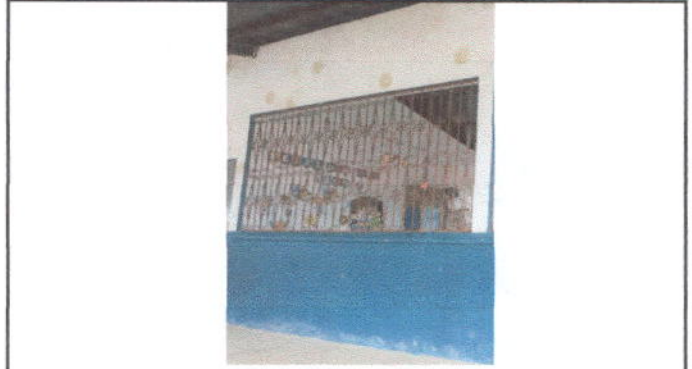
Foto 4: Mantenimiento de estructura de metal de ventana
