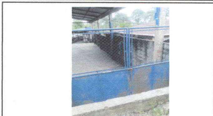
Foto 8: Mantenimiento a portones de metal
