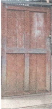
Foto 13: Fabricación e instalación de puerta de metal en cocina
