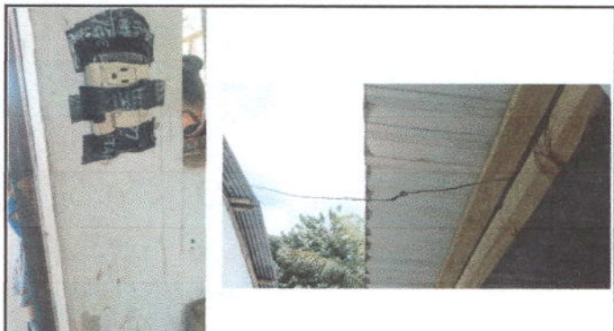
Foto 10: Reparación de cableado eléctrico
