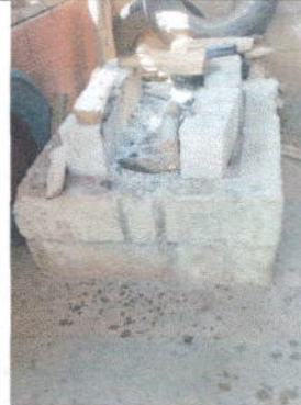
Foto 16: Sustitución de estufa rural completa, incluye chimenea y plancha de metal
